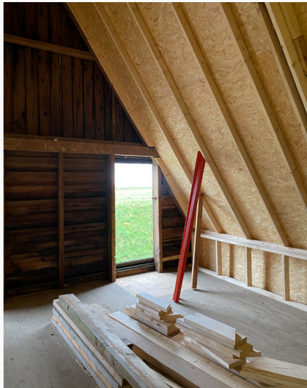
Houtskelet deels opgebouwd uit circulaire OSB-platen t.b.v. isolatiepakket
