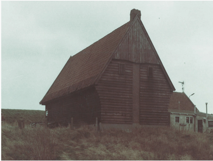
Dijkmagazijn Scharwoude achtergevel, archiefbeeld Provinciale Atlas Noord-Holland
