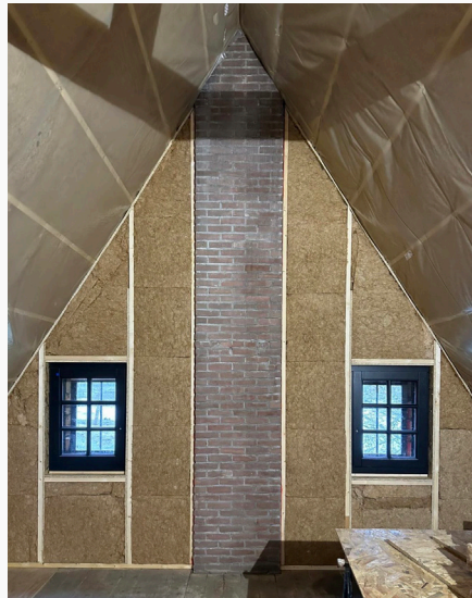
Houtskelet deels opgebouwd uit circulaire OSB-platen t.b.v. isolatiepakket
