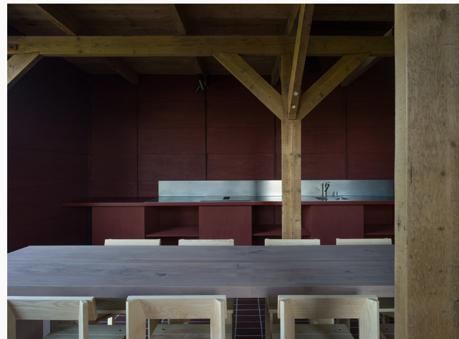
Opgeschoonde en versterkte parapluukolom in het nieuwe interieur
